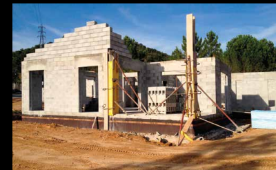
Contrôle des travaux Work control
